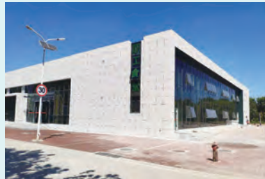
▶ 新建橋箱公司食堂
